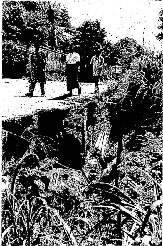
Fig.7.Affouillement sous la chaussée.
