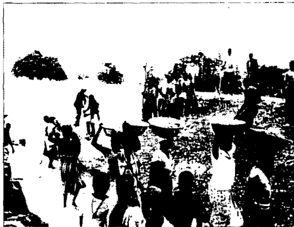
Une réalisation du PDIZB dans le village de Niaga/Bagassi d'où une mobilisation autour du chantier.
