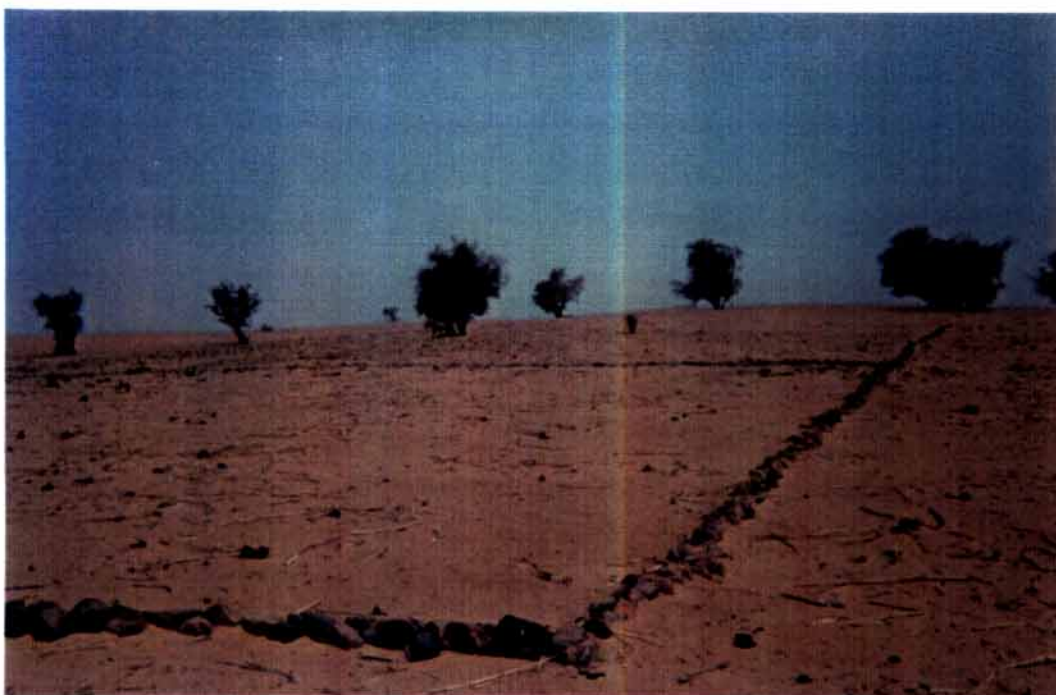
Diguette construite sans tenir compte des courbes de niveau à Gandéfabou Kel Ewel (champ du Délégué)
