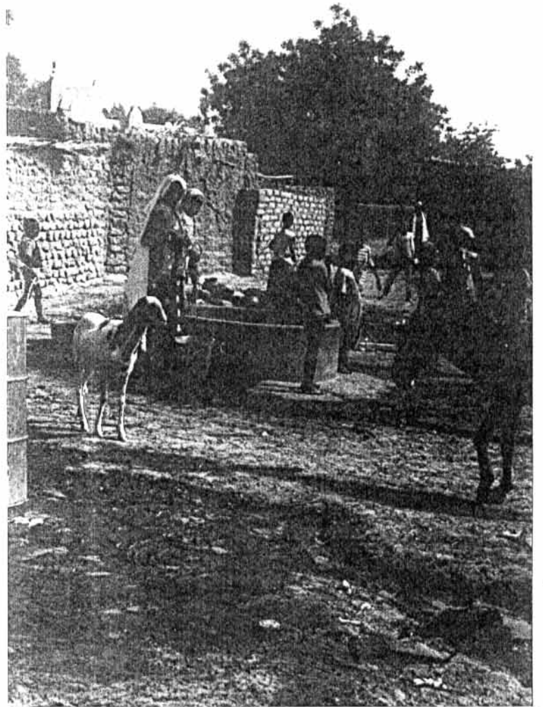
Planche n°14 Exhaure de l'eau d'un puits moderne à l'aide d'une puisette. Meilleure protection des abords immédiats du puits basé contre le ruissellement et l'infiltration de l'eau.
