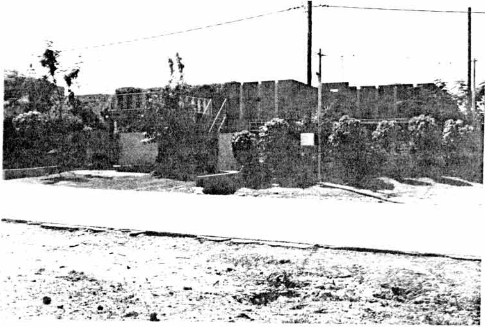
Une villa épargnée au moment du démolissement. Elle fait aujourd'hui partie du patrimoine de la Cité AN III.
