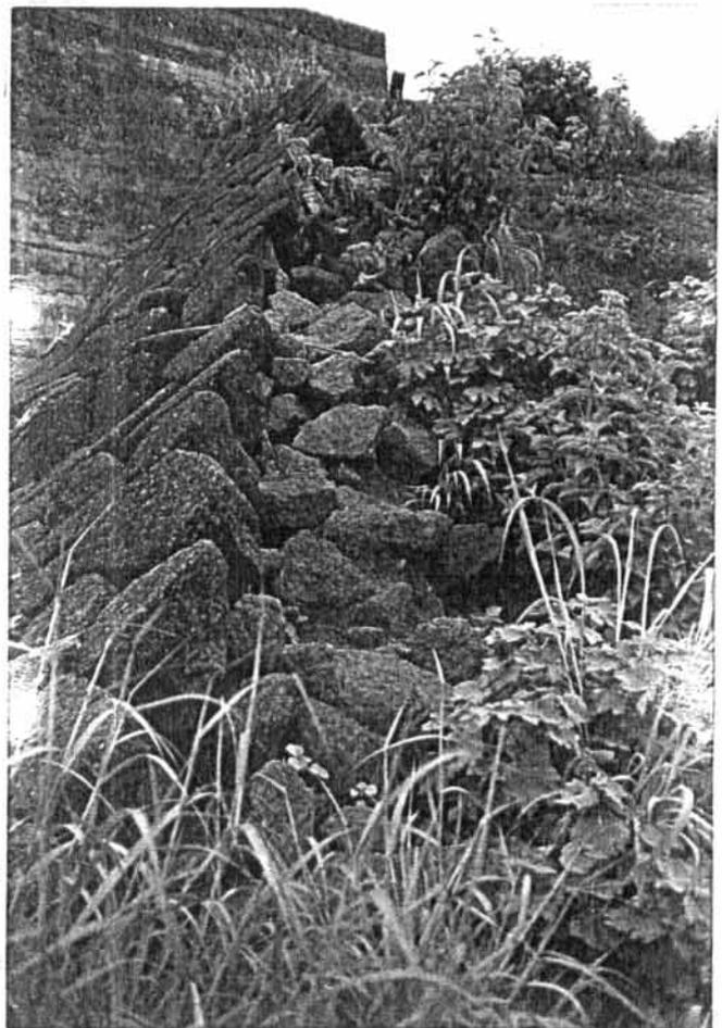
PHOTO N°14 : Démantèlement des gabions ferrugineux du pont N°1 ; action du ruissellement en nappe.
