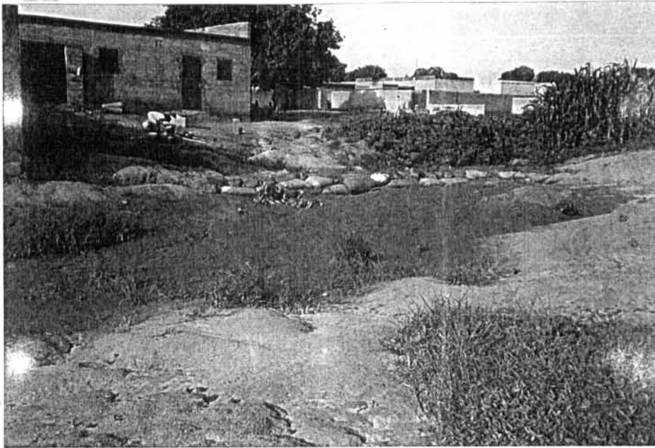
**PHOTO N°3** : Maisons construites dans le lit de la ravine de Colma. Dispositif anti-érosif de fortune servant aussi de voie d'accès à la maison à gauche.
