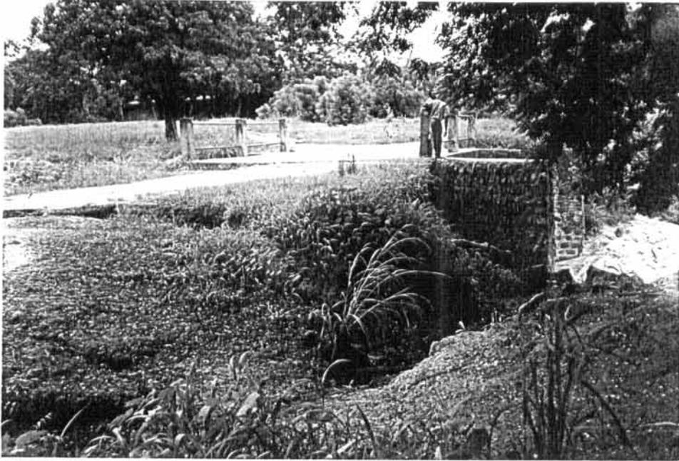
**PHOTO N°7** : Une tête de ravine au-dessus du flanc droit du pont N°5. Remarquer l'isolement du pilier et son effondrement partiel
