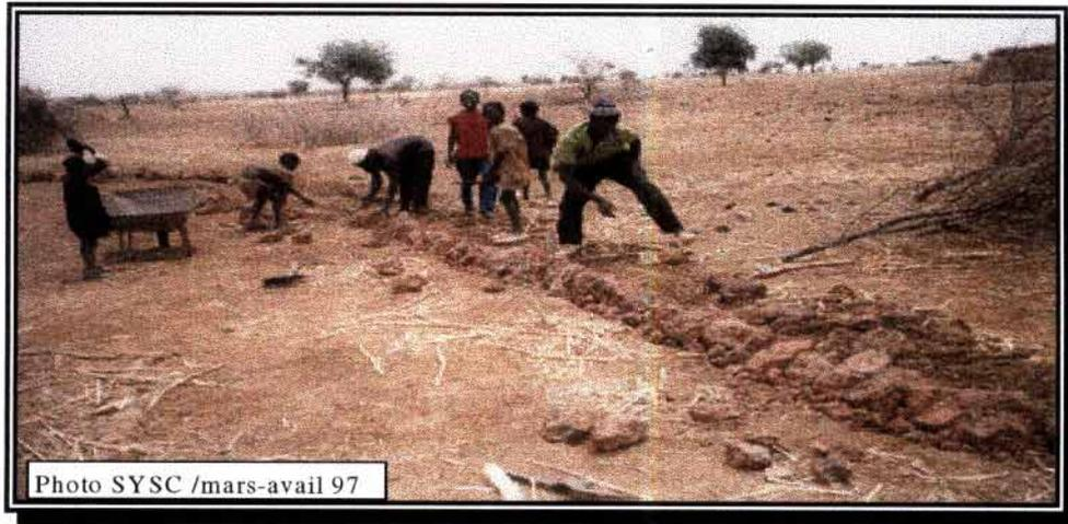
photo 1 : construction de diguette en pierre
