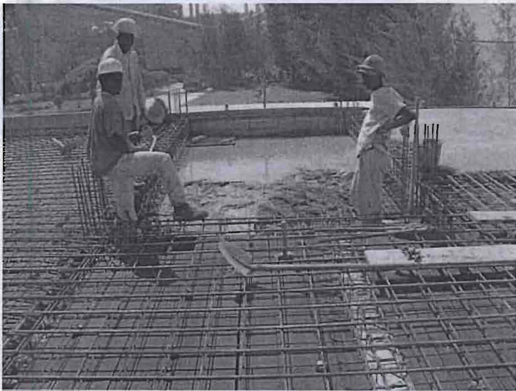
Coulage Plancher Haut Etage
