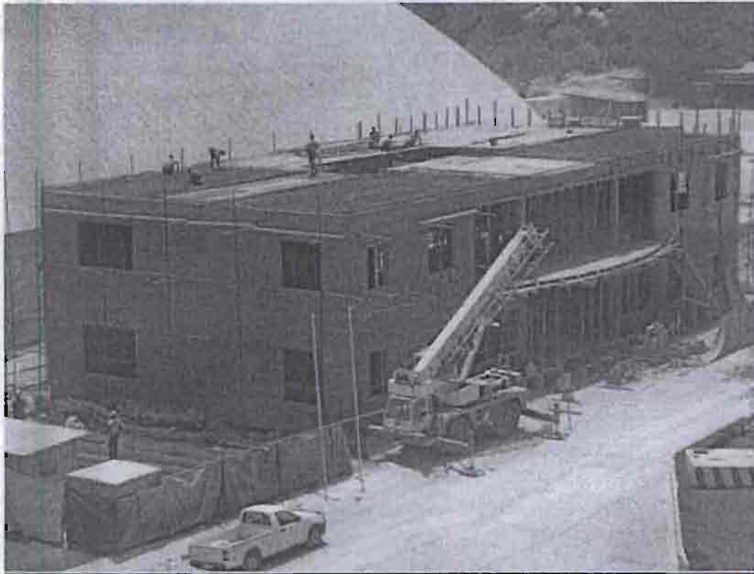
Coffrage et Ferrailage Plancher Haut Etage
