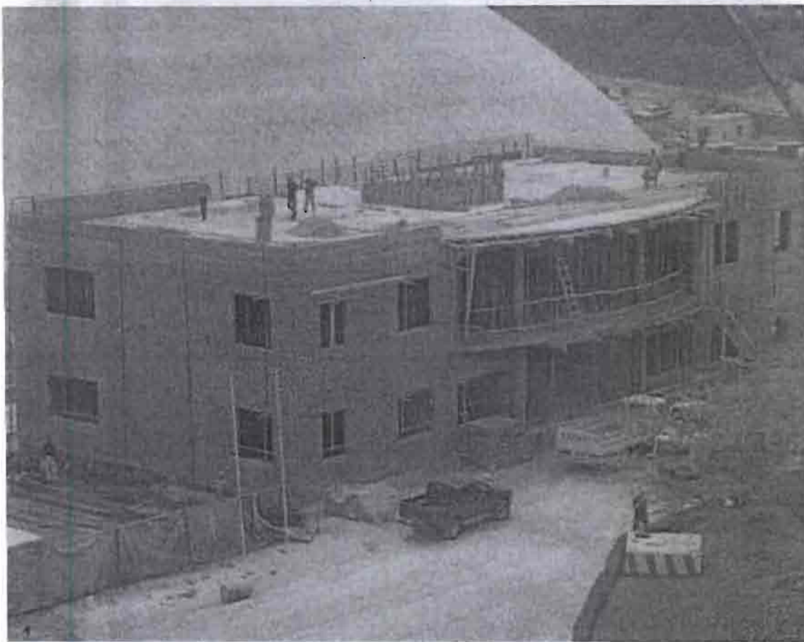
Après Coulage Plancher Haut Etage
