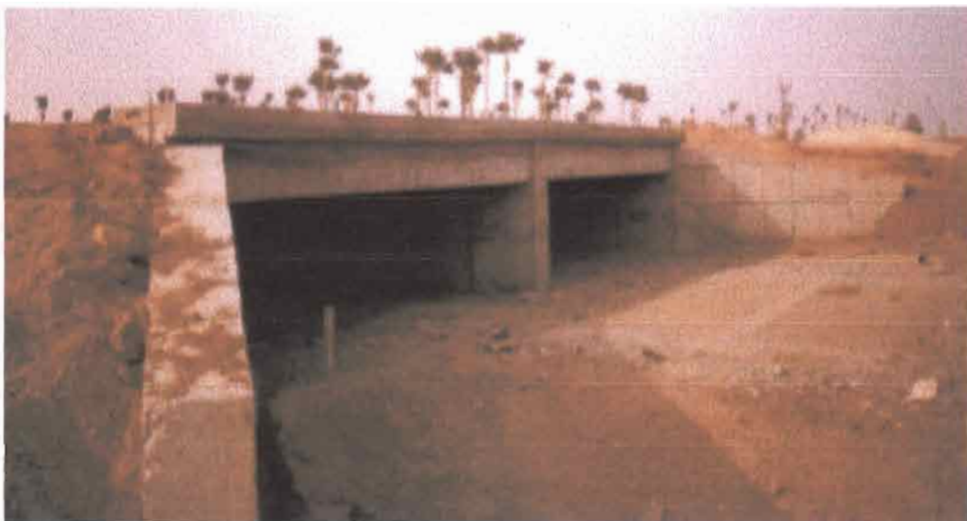
Figure 4.1 : Vue latéral du pont
