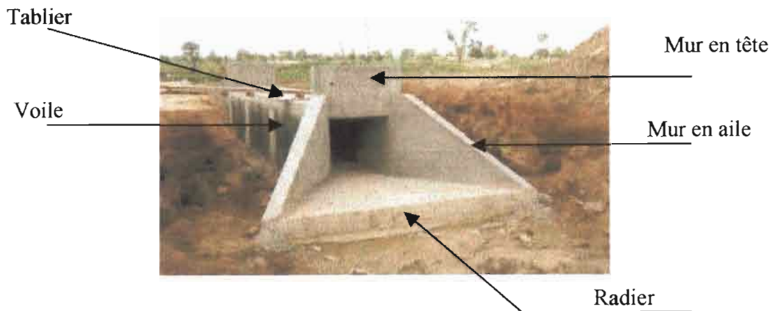
Figure 1.2 : schéma d'un dalot cadre
