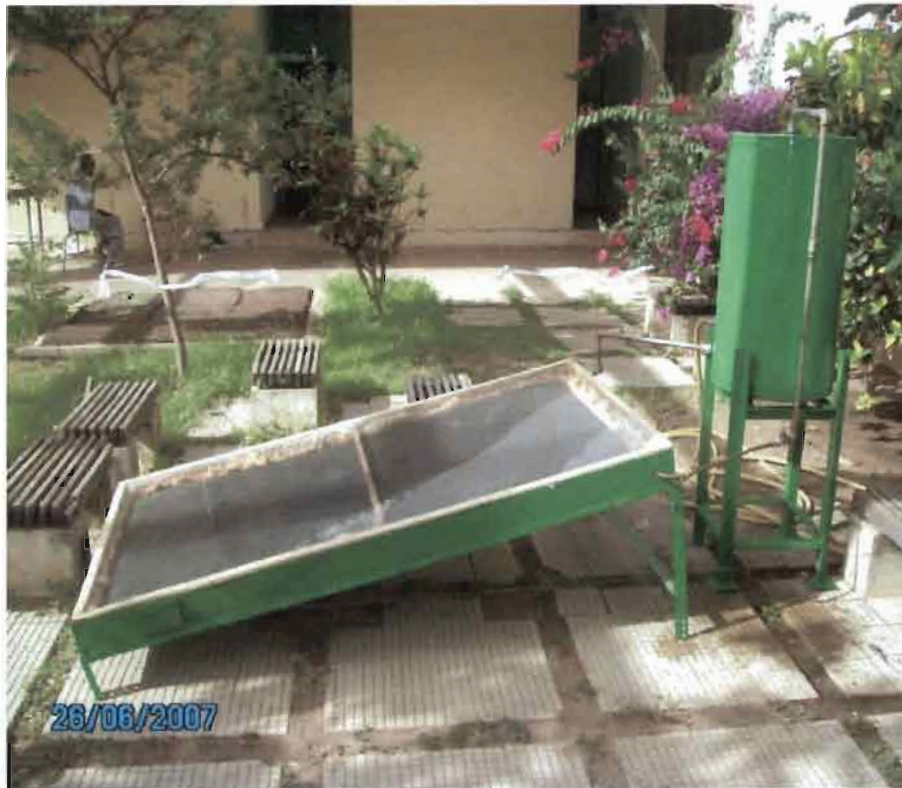
17. Ensemble capteur-réservoir
