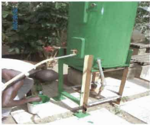
16. Peinte du support du réservoir (1)
