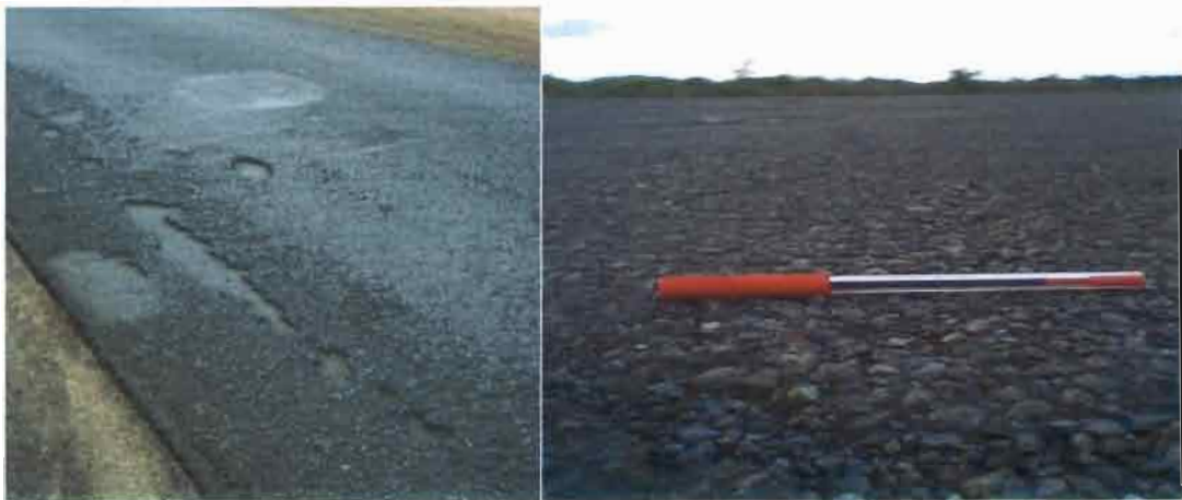
Figure III.15 : Réseau de plumage (RN2)
