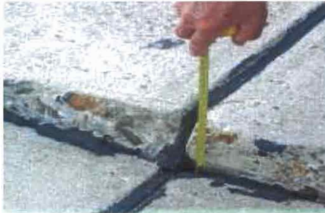
Figure III.34 : Exemple de décalage
