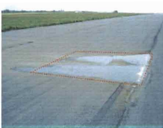
Figure III.29: Remontée d'eau
