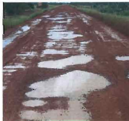
Figure IV.8 : Nid de poule illustré par la flaque d'eau Figure IV.9 chapelet de nids de poules
