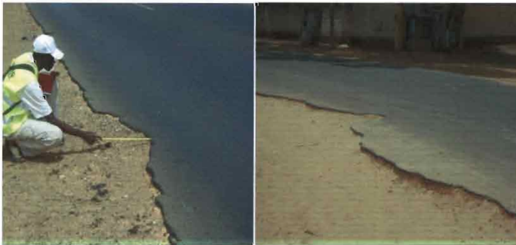
Figure III.22 : Début d'épaufrures (RN2)
