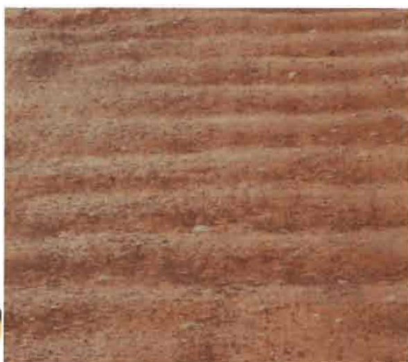
Figure IV.4: Exemple tôle ondulée (Tambacounda)
