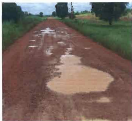
Figure IV.8 : Nid de poule illustré par la flaque d'eau Figure IV.9 chapelet de nids de poules
