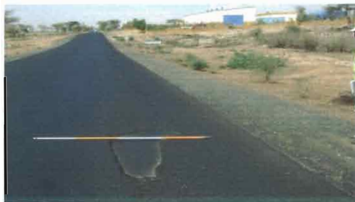
Figure III.16 : Exemple de Pelade (RN2)
