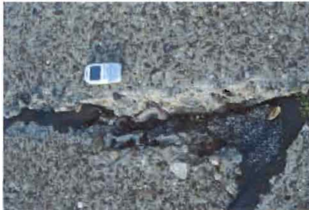
Figure III.33 : Épaufrure caractérisée par le départ de matériaux
