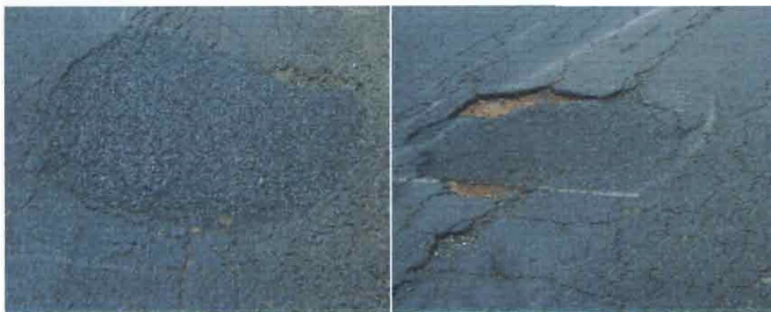
Figure III.24: Exemple de réparation (RN3) Figure III.25 : Réparation dégradée
