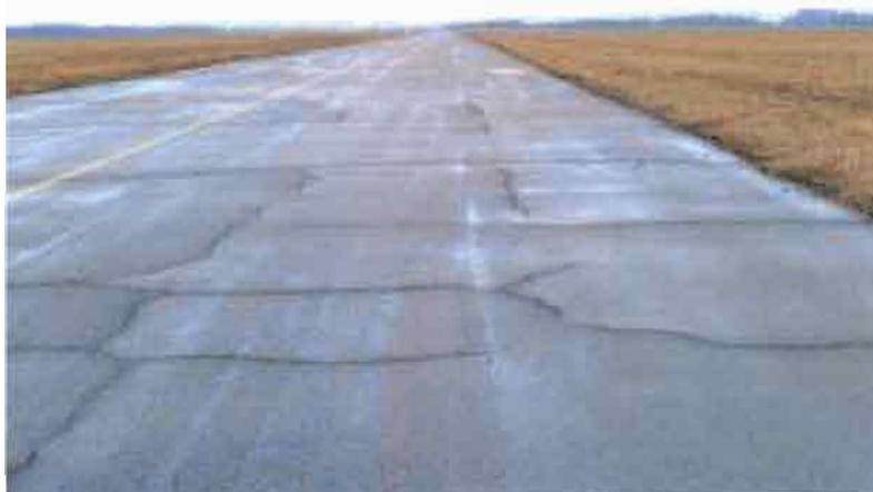
*Figure III-9 Fissure polygonale (source : réf [21])*
