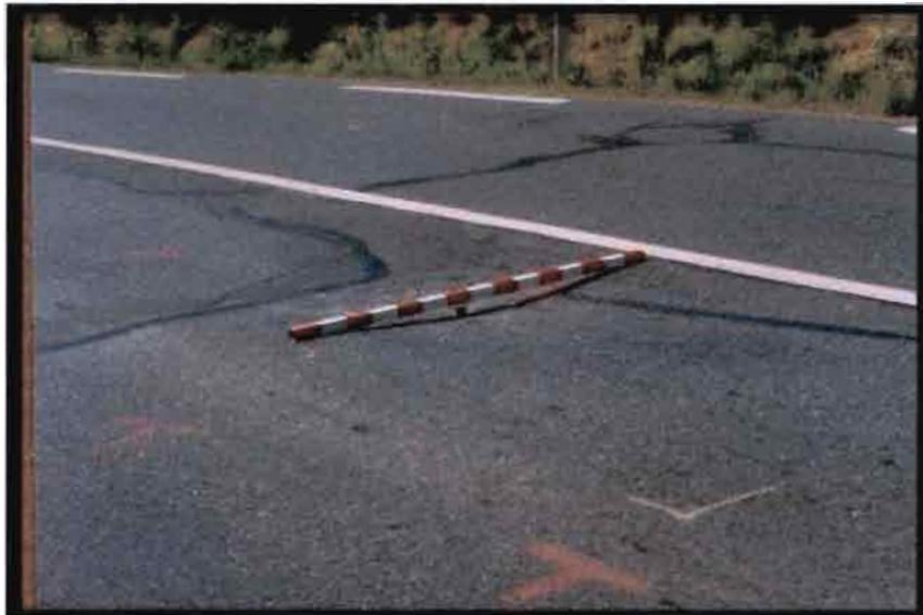
*Figure III-14 Affaissement hors rive ou flache (source : réf [20])*
