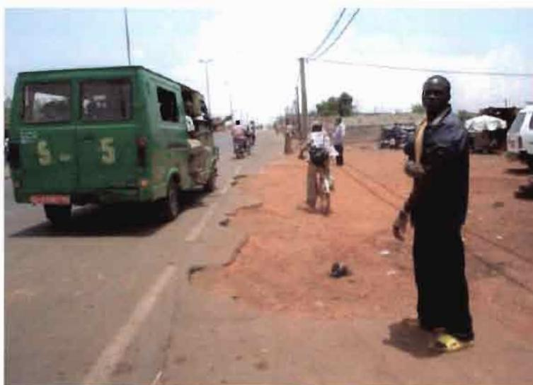
*Figure III-23 Epaufrures (source : réf [15])*
