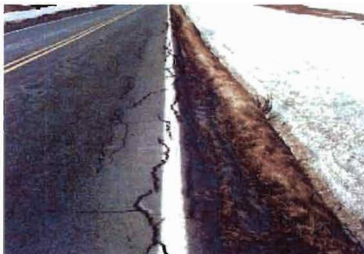
*Figure III-5 Fissures latérales (source : réf [21])*
