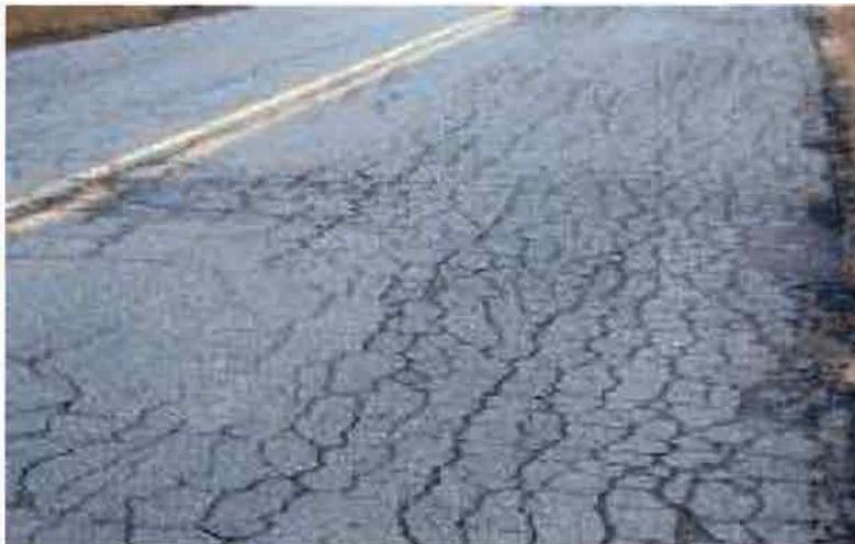
*Figure III-6 Fissures en carrelage ou faïençage (source : réf [23])*
