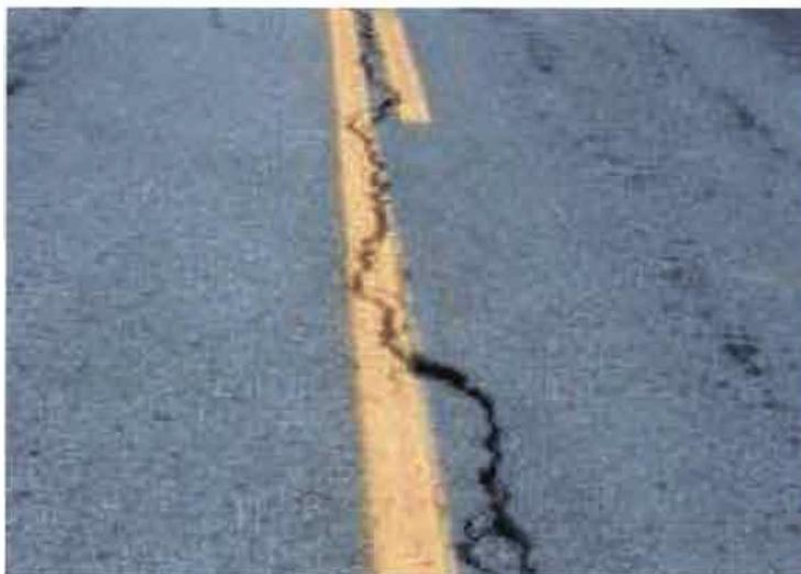
*Figure III-4 Fissures de joint (source : réf [21])*
