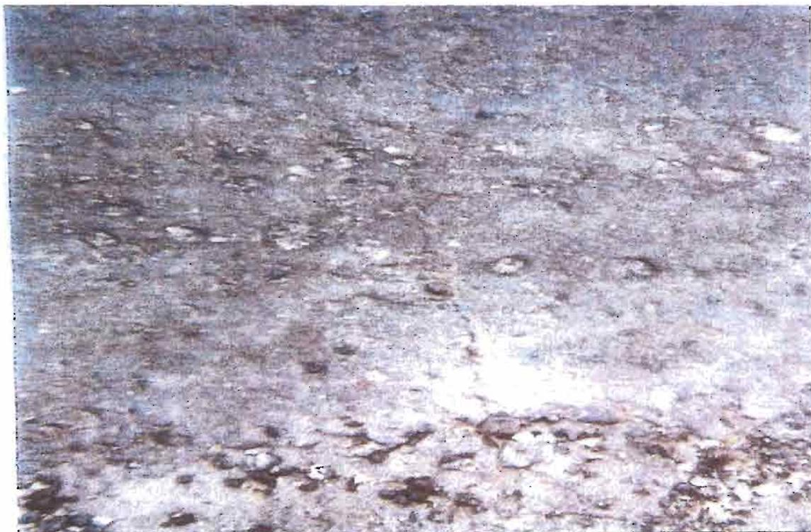
Photo n°14 : Fissures de retrait thermique sur l'accotement imprégné (au PK 194+200)
