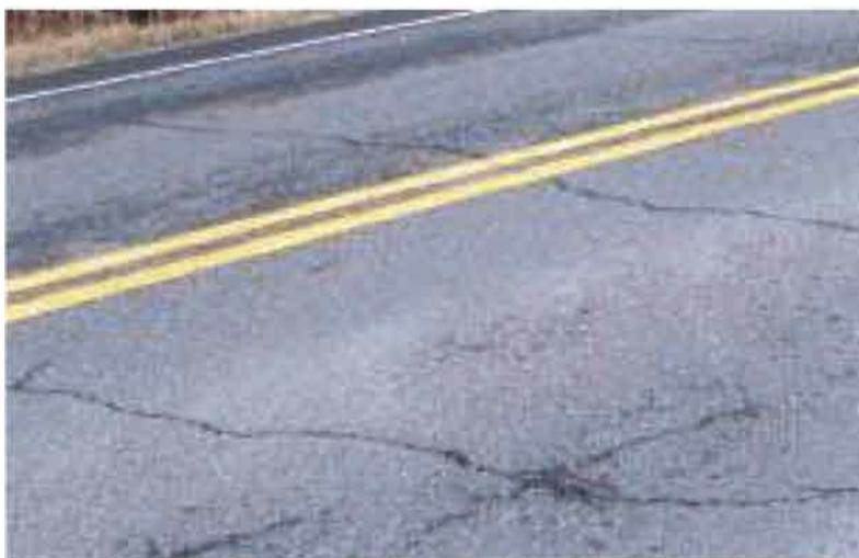
*Figure III-1 Fissures transversales (source : réf [23])*
