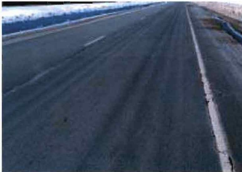
*Figure III-17 Tôle ondulée (source : réf [21])*
