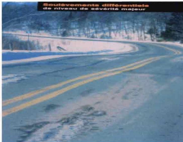
*Figure III-15 Soulèvement différentiel (source : réf [23])*
