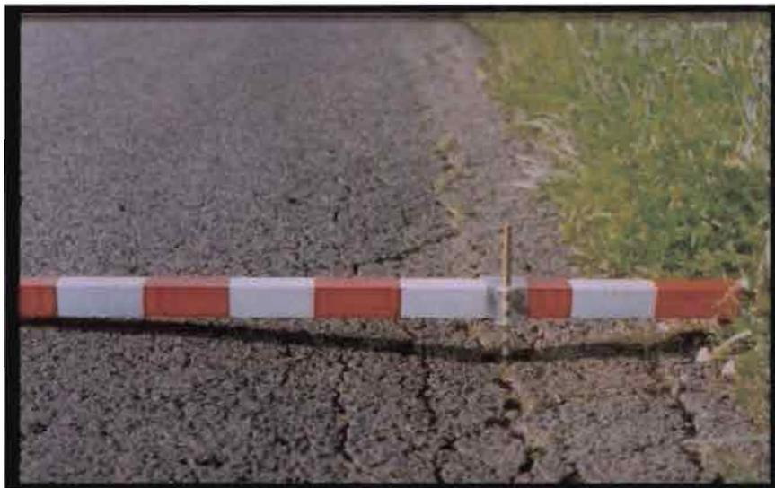
*Figure III-13 Affaissement de rive (source : réf [20])*
