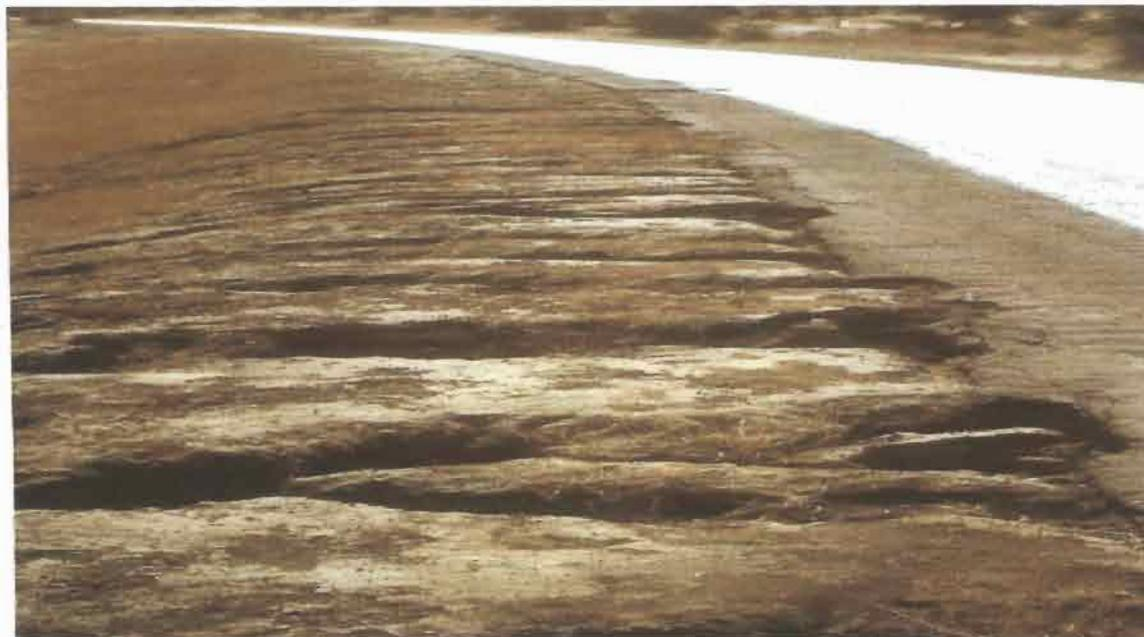
Photo n°7 : Par endroit des griffes d'érosion se forment (cas des zones en remblai)
