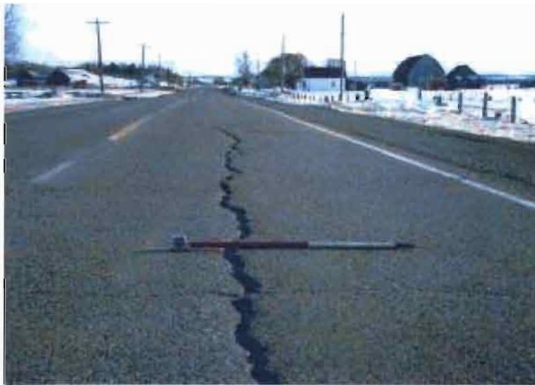
*Figure III-3 Fissures longitudinales (hors pistes de roue) (source : réf [23])*
