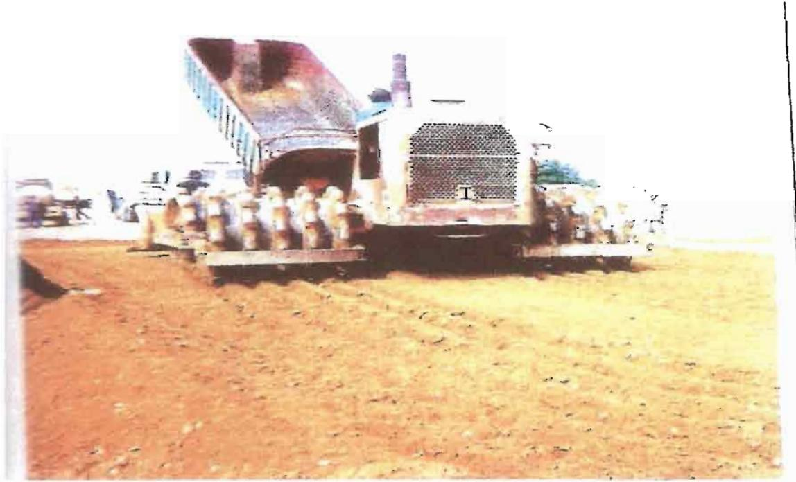
Photo n°11 : Etalement du mélange au pied dameur équipé d'une lame frontale
