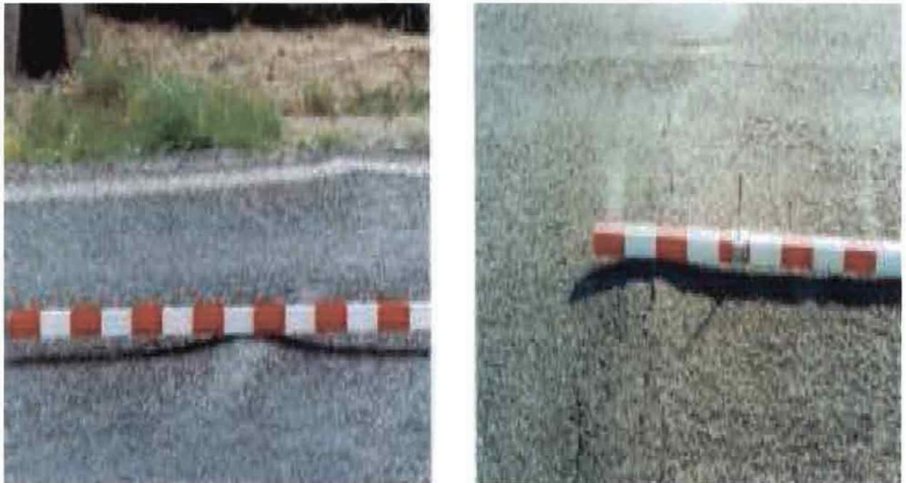
*Figure III-16 Bourrelet transversal (source : réf [21])*
