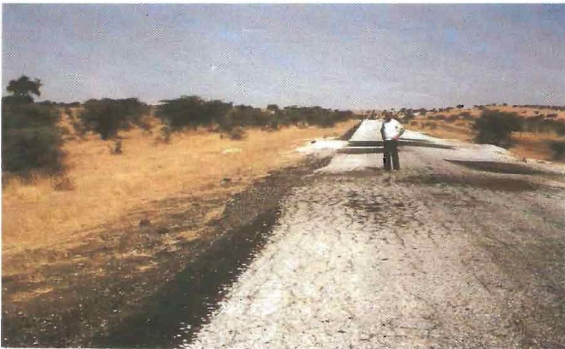
Photo n°6 : Par endroit ce maillage se propage sur la chaussée revêtu. (Source réf. [16]).
