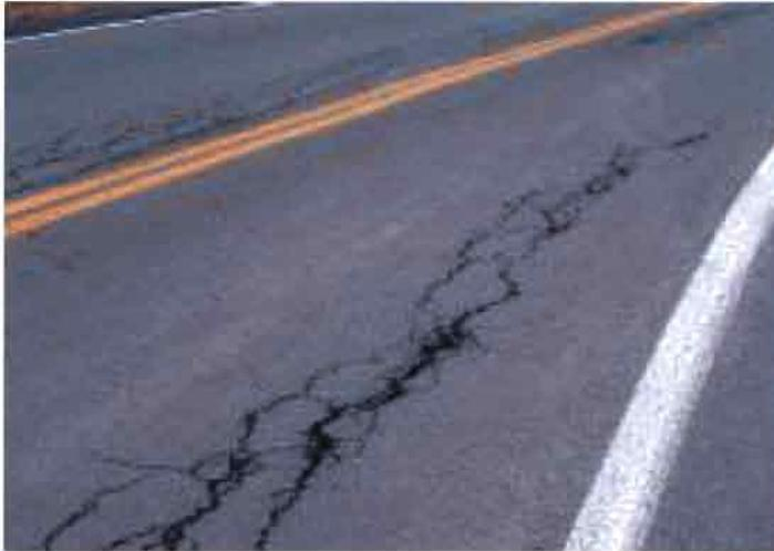
*Figure III-2 Fissures en pistes de roue (source : réf [23])*
