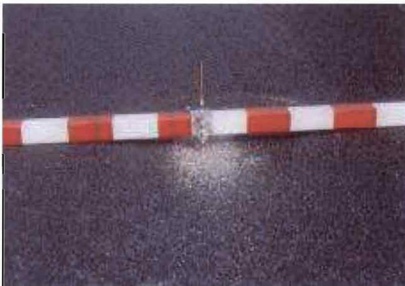
*Figure III-22 Remontée de fines (source : réf [21])*
