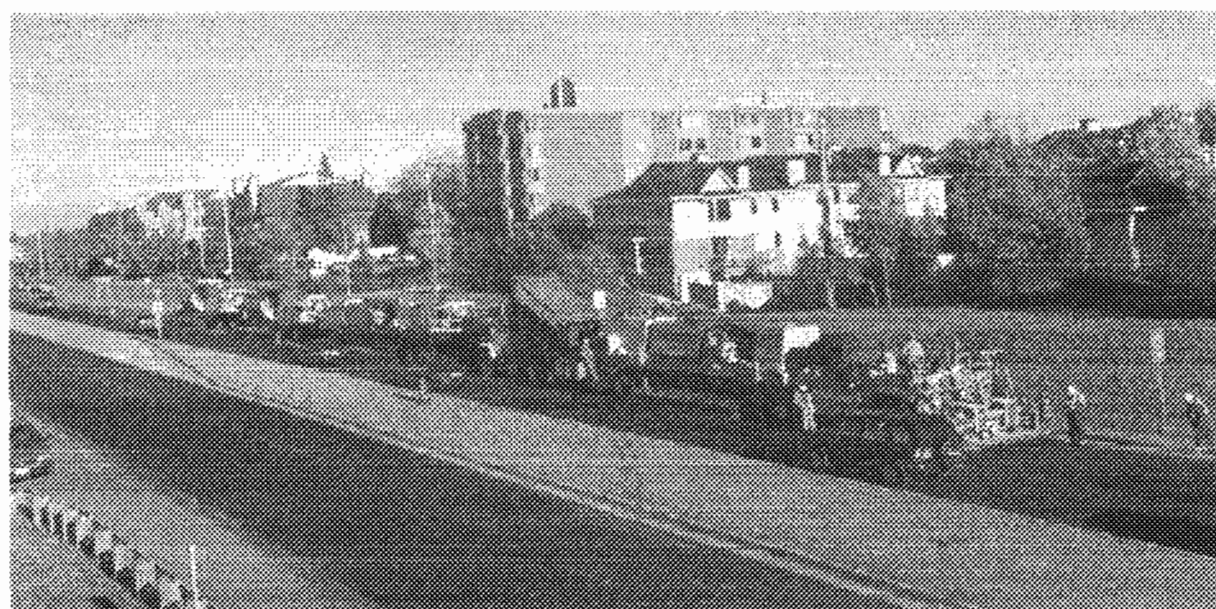
Figure 4.4. : Chaîne de recyclage en place par thermorégénération en train de réhabiliter une chaussée municipale en une seule passe.
