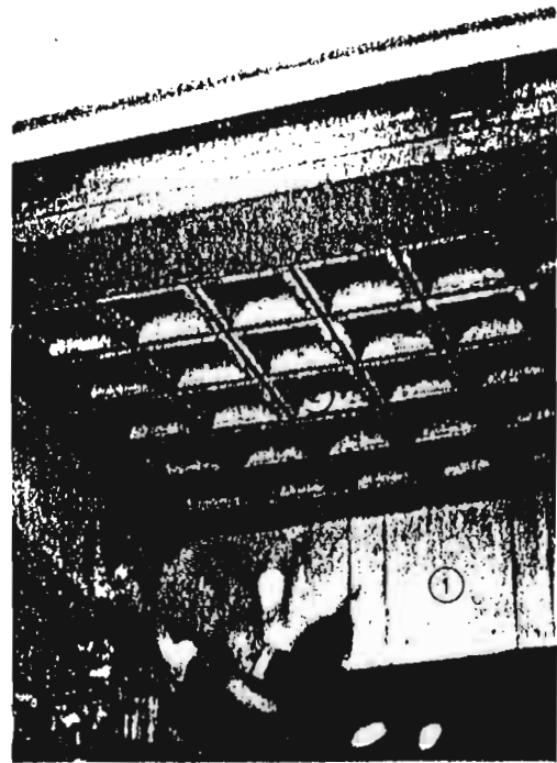
Fig. 6. — Bâtiments de plusieurs étages montés sur poutres précontraintes (1) séparées par des caissons décoratifs (2). (1) béton de sable avec ajouts de gravillons (G/S = 1). (2) béton de sable avec fines (G/S = 0).
