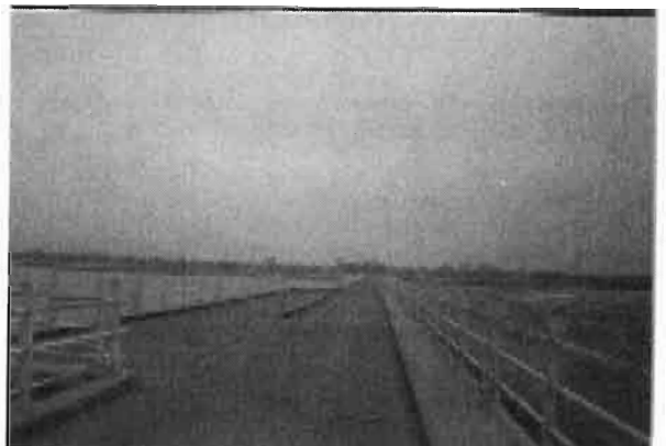
Photo 1. La zone de garage du tablier
