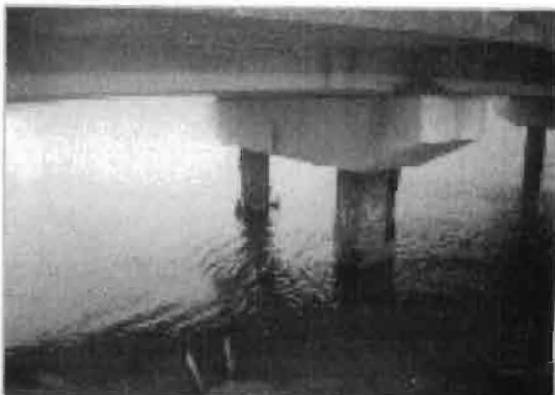
Photo 3. Piles dégradées
