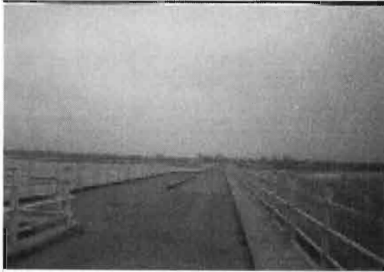
Photo 1. La zone de garage du tablier
