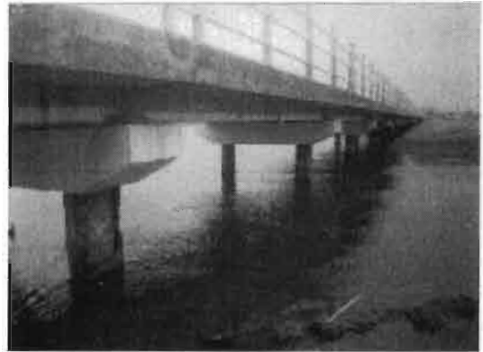
Photo 2. Le Tablier, les chevêtres et les piles
