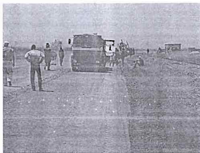
PHOTO N°1 : PREPARATION DE LA PARTIE DE L'ACCOTEMENT DEVANT SERVIR A L'ELARGISSEMENT
