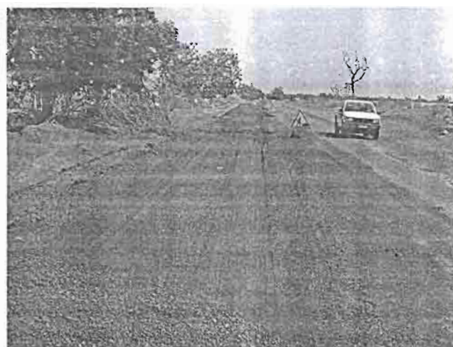
PHOTO N°2 : MISE EN ŒUVRE DE LA LATERITE CRUE D'APPORT
