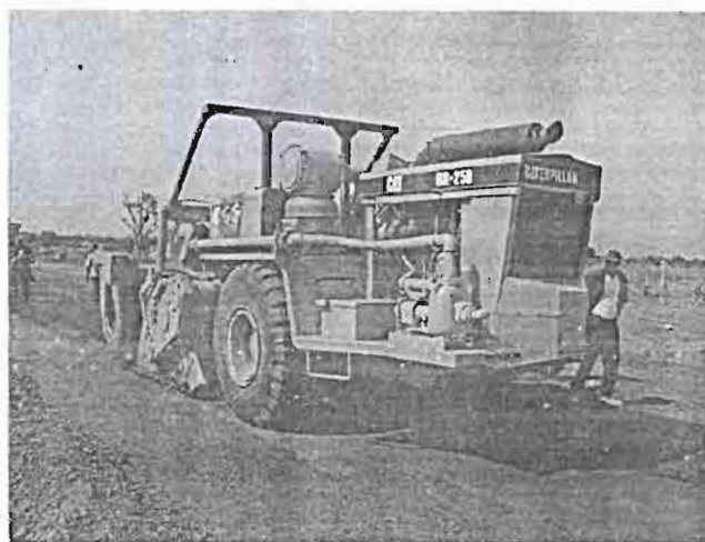
PHOTO N°3 : DECOHESION DES MATERIAUX DU REVETEMENT ET DE LA COUCHE DE BASE AVEC LA RECYCLEUSE RR 250 (PULVIMIXER)
