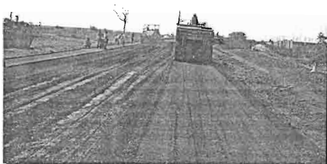
PHOTO N°6 : COMPACTAGE DE L'ENSEMBLE
