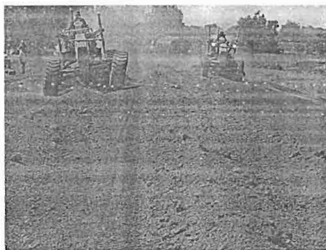
PHOTO N°4 : MELANGE ET REGLAGE A L'AIDE DE LA NIVELEUSE
