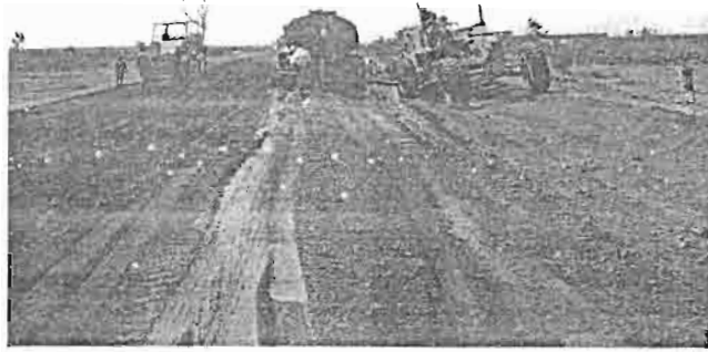
PHOTO N° 5 : ARROSAGE DU MELANGE HOMOGENEISE
