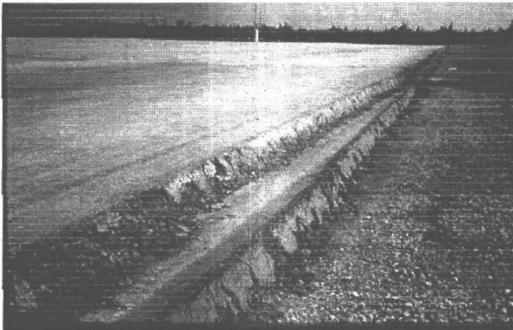
b. Chantier en cours de construction
