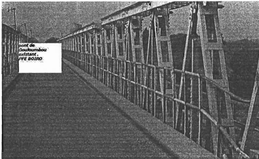
Figure 2.a : vue de la chaussée du pont existant
