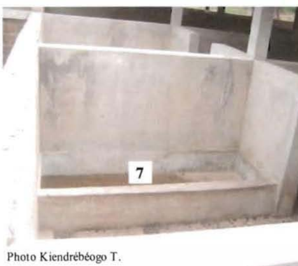
Photo 4: Baignoire (7) en maçonnerie fixe dans une loge d'un bâtiment de type A
