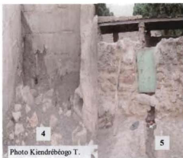
Photo 12 : Dépôt de déjections (4) et système de drainage du purin (5) dans une UP de type C
