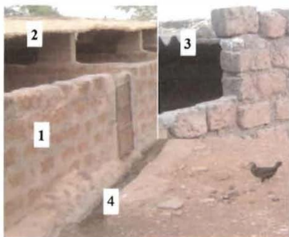
Photo 5: Habitat de type B construit en pierre taillée (1) toit en tôle recouvert de secco (2) et de tuile (3) avec système d'évacuation rudimentaire
