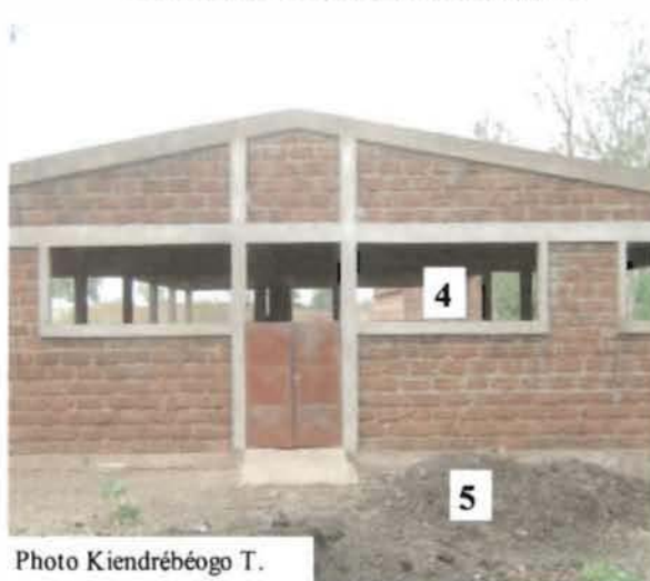
Photo 2: Système d'aération (4) et dépôt de déjections (5) devant un bâtiment de type A
