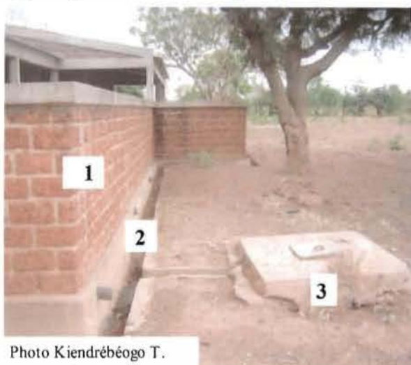
Photo 1: Habitat de type A construit en pierre taillée (1) avec système d'évacuation du purin (1 et 2)
