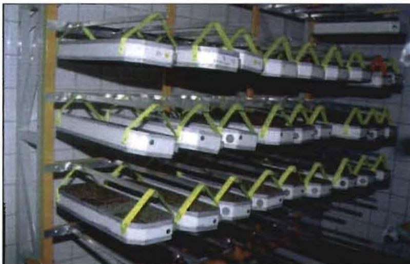
Figure 9 : Système de stockage dans le TPU-2
