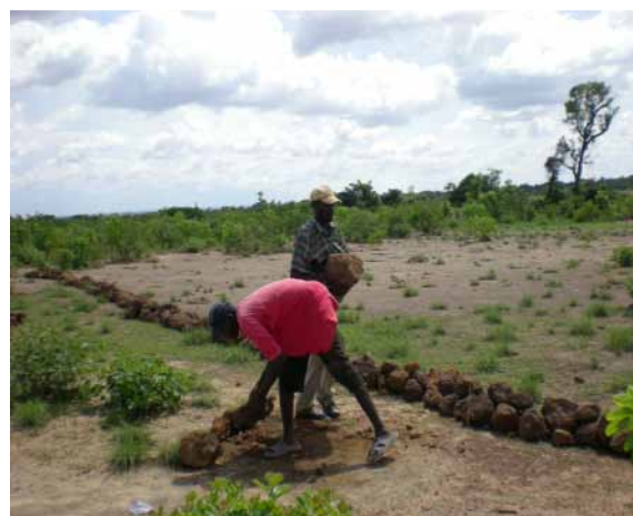
Construction de cordon pierreux
