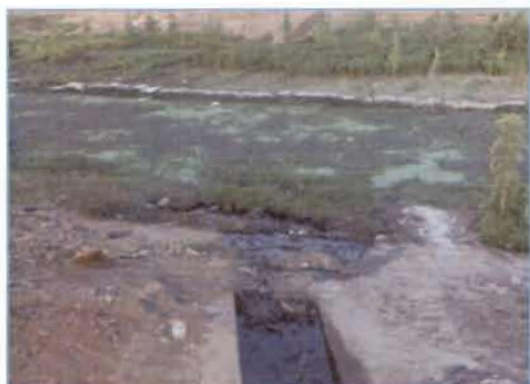
Photo 1: Rejet d'eaux usées le long du canal central (Wayalghin)
